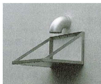
図17) ヘリウムガス排気口の開口部施工例
