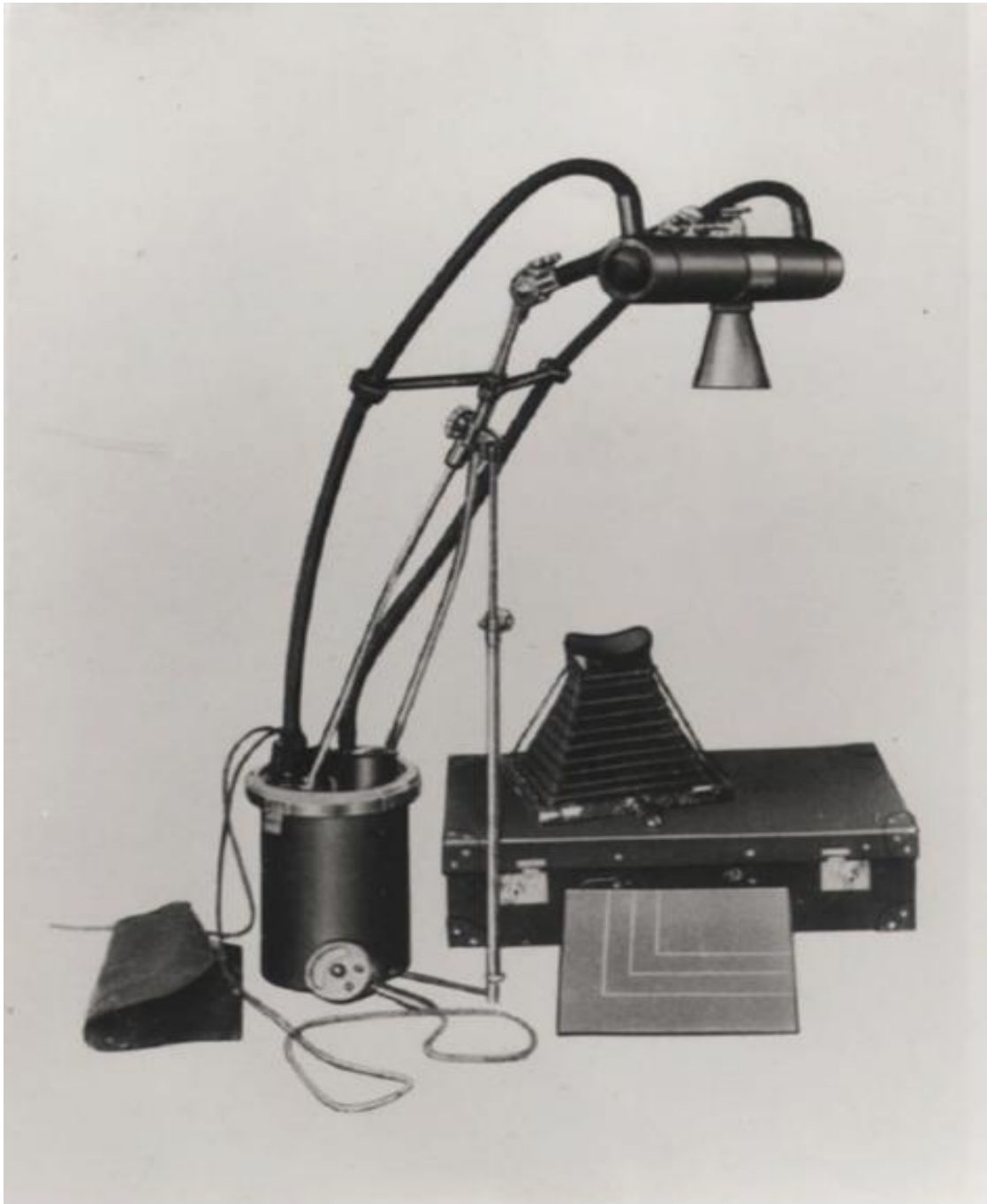
昭和6年(1931年)発売 ポータブルエックス線 撮影装置「醍醐号」 当時のエックス線装置はほとんどが数万ボルトの高電圧が露出し暗室で扱われていたが、 この装置は防電撃型の先駆になった。
