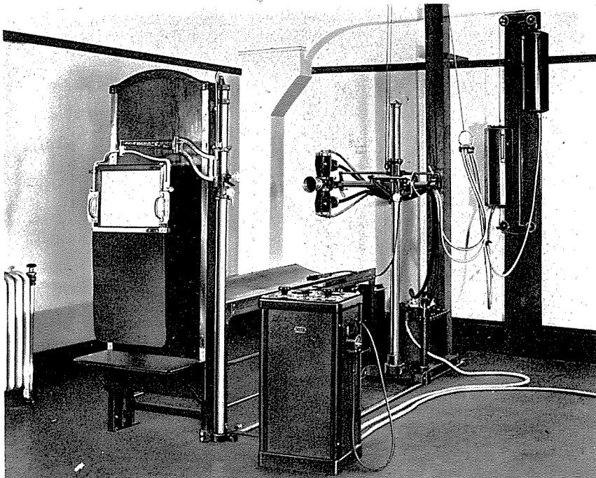
本装置は普及型装置として設計製作せられたものであります。その性能は無整流装置の及び得る最高限界に及ぶものであります。之は變壓器、制御卓子、高壓電纜、エックス線管容器、透視装置等の各構成部分が夫々の機能を完全に發揮し得る様綜合的に計画せられた爲であり、最少の経費を以て一般エックス線診断を遂行し得る驚異的裝置であります。必要な附屬品はすべて取揃へたセットとなつて居ります。
